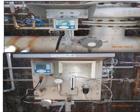
เครื่องตรวจวัด pH และ Conductivity บริเวณบ่อกักน้ำทิ้ง ขนาด 9,600 ลูกบาศก์เมตร
