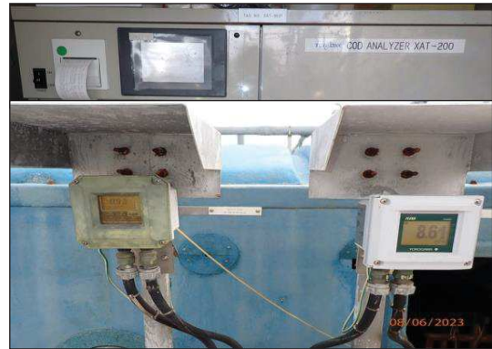
เครื่องตรวจวัด pH และ COD แบบอัตโนมัติ บริเวณบ่อฟักน้ำทิ้งจากระบบบำบัดน้ำเสีย (RO-BiO)
