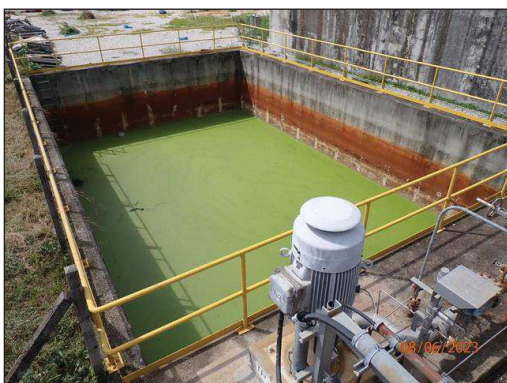
บ่อรวบรวมน้ำฝนปนเปื้อนบริเวณลานล้าง
