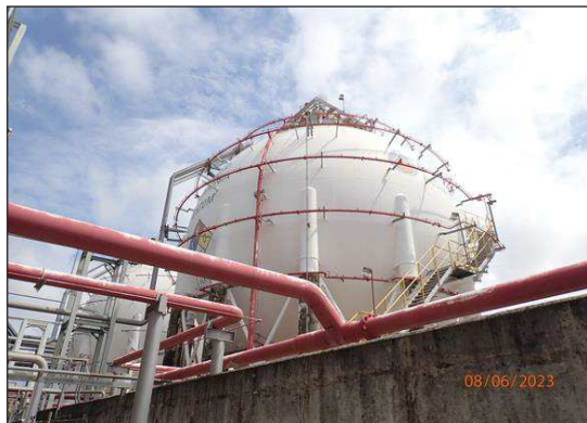
รูปที่ 3-41 ระบบดับเพลิงบริเวณถังแอมโมเนียและโพรเพน
