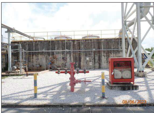
รูปที่ 3-42 บ่อรวบรวมและปรับสภาพ สารละลายแอมโมเนียมไฮดรอกไซด์ที่หกั่วไหล
