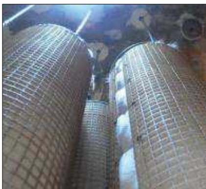
รูปที่ 3-5 การตรวจสอบ Demister ด้วยสายตาของปล่อง SAR ช่วงหยุดซ่อมบำรุงประจำปี
