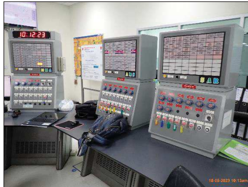
ตัวอย่าง Emergency shutdown system – ESD Control Panel ของ MMA Plant สามารถสั่งหยุดระบบกรณีพบการรั่วไหลได้ในห้องควบคุม
