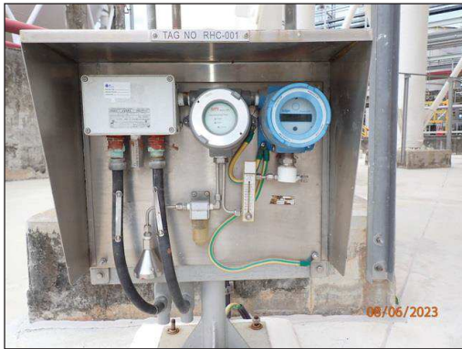
Gas Detector บริเวณถังเก็บกากโพรเฟน
