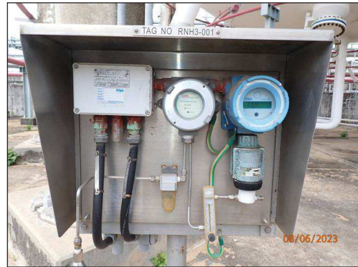
Gas Detector บริเวณถังเก็บกากแอมโมเนีย
