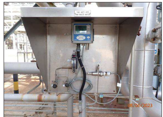
เครื่องตรวจวัด Conductivity บริเวณบ่อบำบัดน้ำทิ้งจาก WWI
