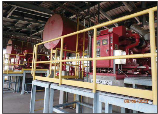
เครื่องสูบน้ำดับเพลิงแบบ Electrical Pump และ Diesel Pump
