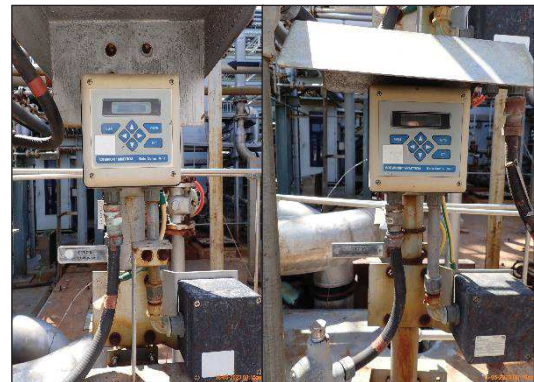
เครื่องตรวจวัด pH และ Conductivity แบบอัตโนมัติ บริเวณบ่อฟักน้ำทิ้งจากหน่วยผลิตกรดซัลฟูริก (SAR)
