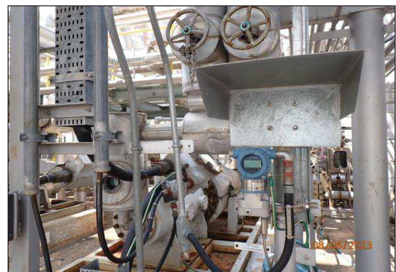
รูปที่ 3-37 อุปกรณ์ตรวจวัดความดันในระบบท่อลำเลียง
