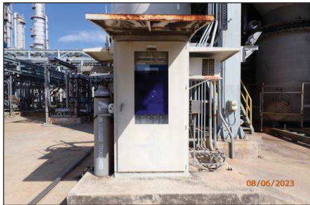
รูปที่ 3-4 เครื่องมือตรวจสอบคุณภาพอากาศจากปล่องแบบอัตโนมัติ (CEMS)
