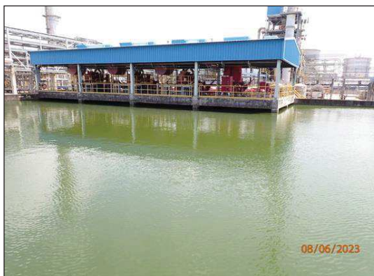
รูปที่ 3-43 บ่อน้ำสำรองดับเพลิง
